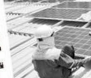
Lắp đặt hệ thống điện mặt trời kiểm điện hiệu quả
