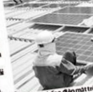
Lắp đặt hệ thống điện mặt trời kiểm điện hiệu quả
